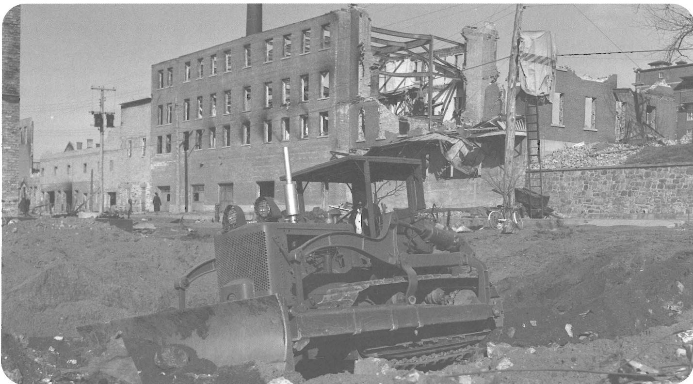
Les travaux de déblayage. (Louis-Paul Lavoie, Au lendemain du feu, 1950, Groupe de fonds Clément Claveau, Collection du Musée régional de Rimouski, N.A.C.: HR-13199)
