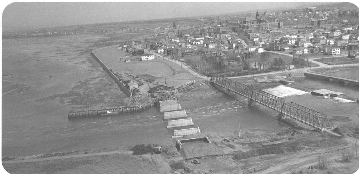
(Louis-Paul Lavoie, Travaux sur le pont enjambant la rivière Rimouski, 1951, Groupe de fonds Clément Claveau, Collection du Musée régional de Rimouski, N.A.C.: HR-13014)
