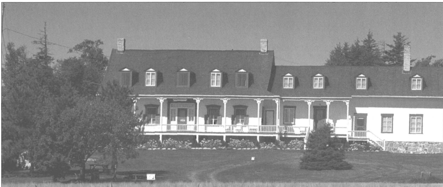
Manoir Taché (Saint-Louis-de-Kamouraska) « Détruit par un incendie en 1885, il fut reconstruit peu après par le soin de l'architecte Cyrias Ouellet, tel qu'il avait été construit au début du XIX e siècle, semble-t-il, toujours sur le cap Taché ». Aujourd'hui cette vaste demeure est devenue l'Auberge manoir Taché. (source : Pascal-Andrée Rhéault, Itinéraires et découvertes culturelles au Bas-Saint-Laurent , Trois-Pistoles, Centre d'édition des Basques, 1999, p. 54.)
