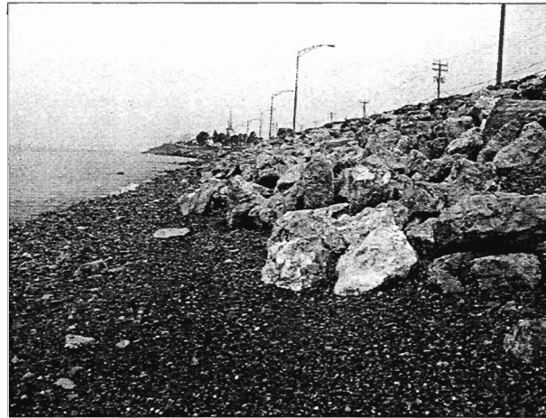
Figure 5.5 Vue vers l'ouest, ouvrages de protection en enrochement le long du secteur B, à marée mi-montante (7 juillet 2006).
