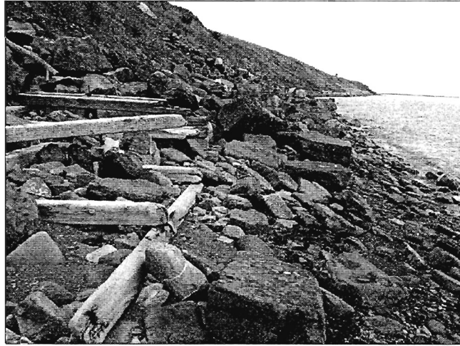
Figure 3.4 Vue vers l'est du secteur de falaises de Saint-Siméon : vestiges d'anciens mur/caissons de bois et enrochements de rivage plus récents, à marée haute (juillet 2006).
