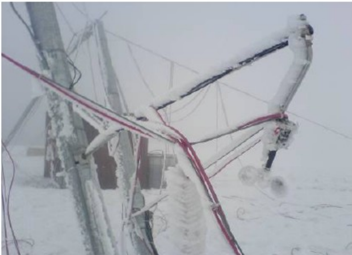
Figure 12: Exemple d'effondrement d'une tour météorologique en raison du poids du givre[34]
