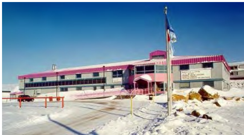
Figure 18: Façade du collège
