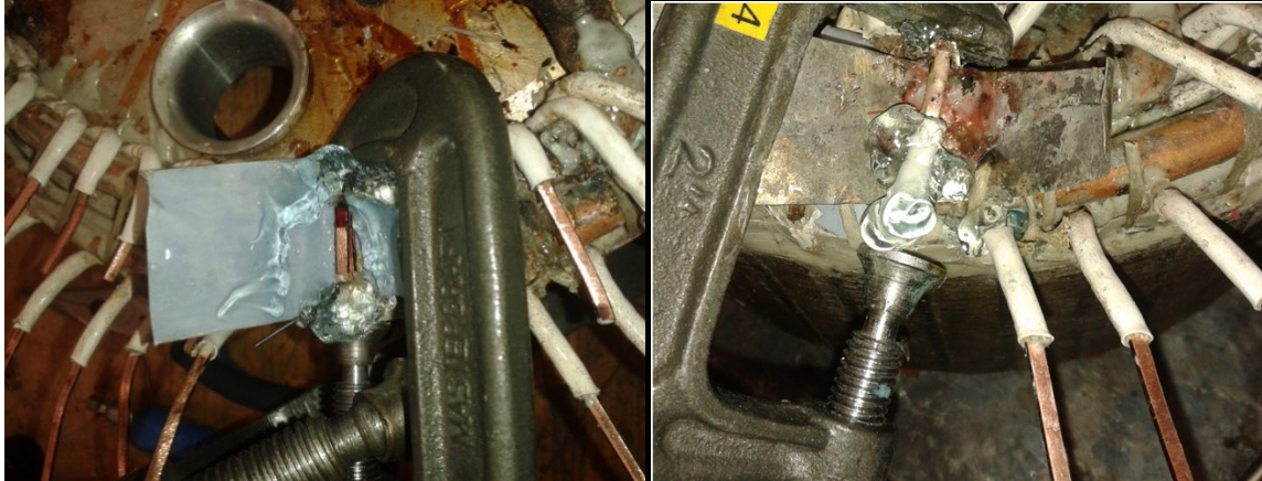
Figure 6.11 :Montage de la zone de travail pour la soudure des bobines des phases du moteur.
